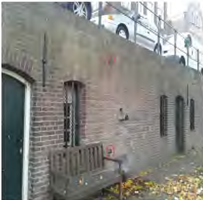
Figuur 4: Voorbeeldfoto positie prisma's (rood omcirkeld)
